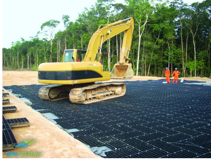
Şekil 5. Geomat ile geçici yol imalatı [Url-4]
