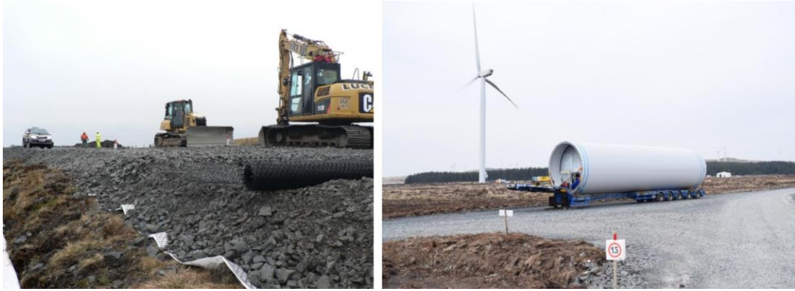
Şekil 4. Geotekstil ve geogrid uygulaması ile yol dolgusu [Url-2]
